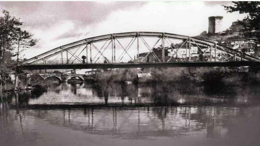
Imagen de la estructura previa que se pretende restituir.
