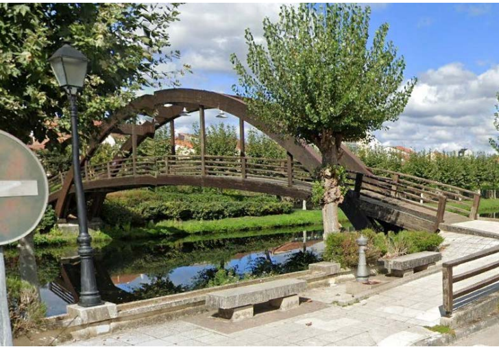
Estructura de madera existente en la zona de implantación
